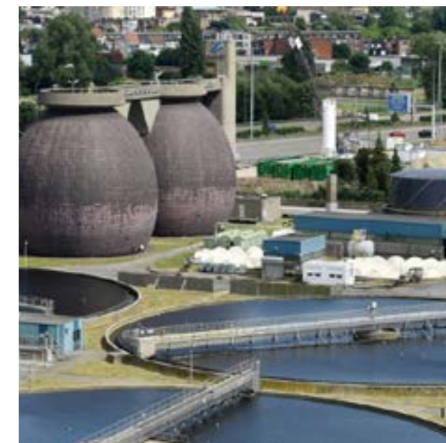
▲ Afvalwaterzuiveringsinstallatie Antwerpen - Aquafin - RWZI Deurne. Bron Foto © Jan Van der Perre. www.vlaanderen.be/waterafvoer-en-riolering
