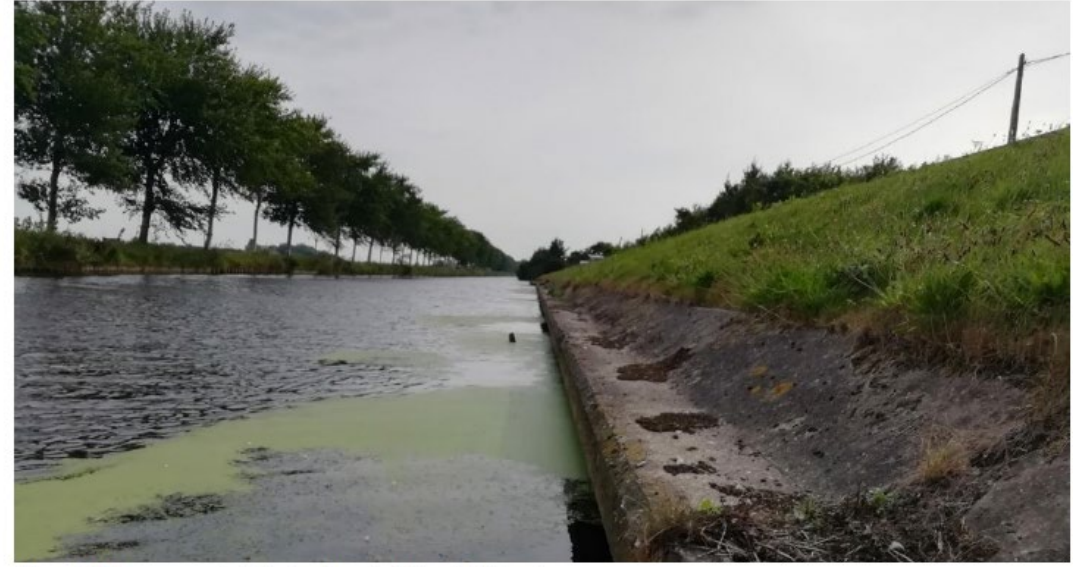
Kanaal Nieuwpoort-Duinkerke, richting Adinkerke.
