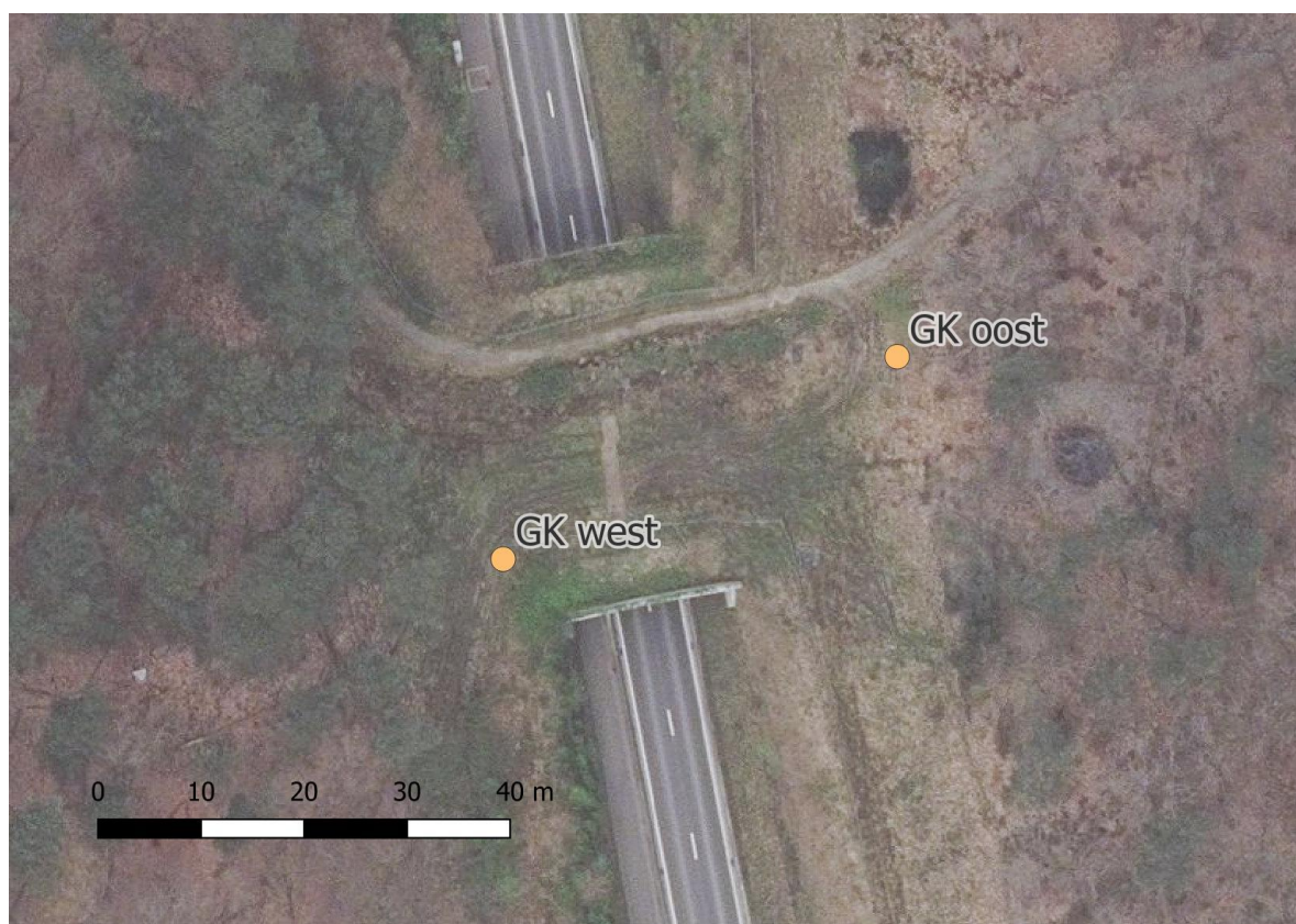
Figuur 11: Locaties van de vleermuizendetectors op ecoduct De Grote Konijnenpijp.
