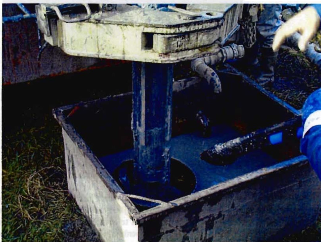
Figuur 4.1 : spoelboring te Maldegem
