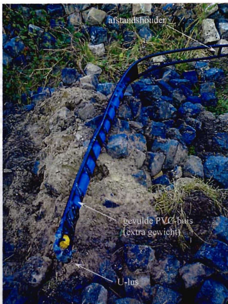
Figuur 4.2 : verticale warmtewisselaar
