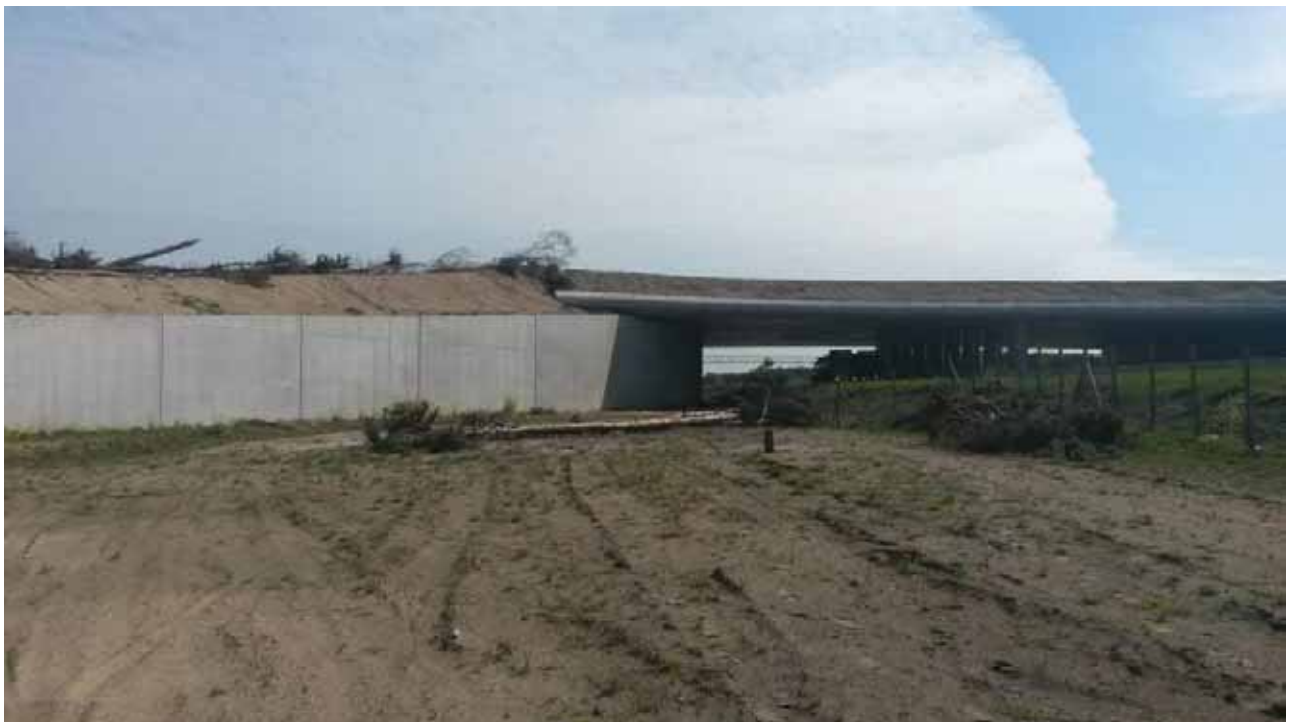
Figuur 6: Zicht op het ecoduct Kempengrens, het eerste jaar na de aanleg. 8 mei 2015. Foto Jorg Lambrechts.
