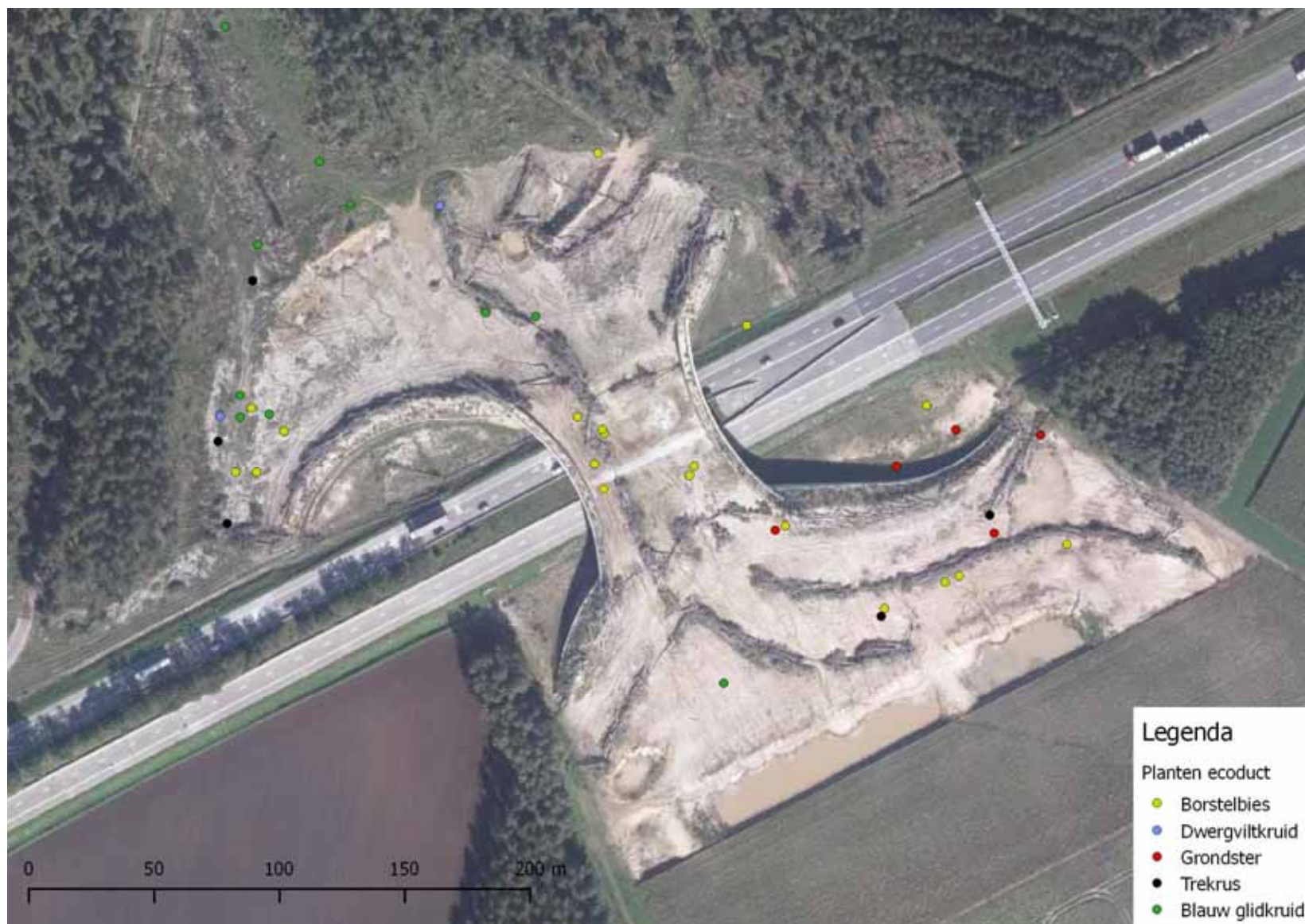
Figuur 16: Detail van het ecoduct Kempengrens met situering van een aantal zeldzame of kenmerkende plantensoorten.
