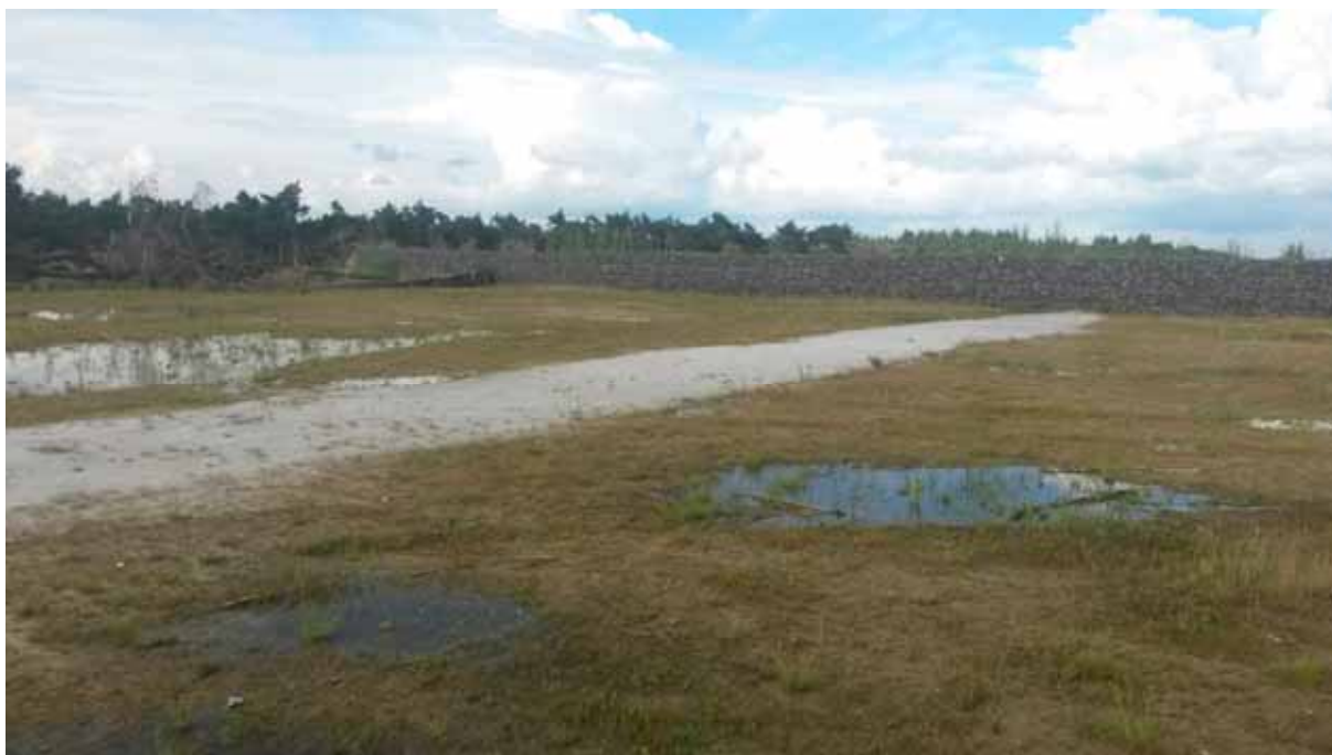
Figuur 18: Zicht op het zandbed centraal op ecoduct Kempengrens. Door de overvloedige neerslag in juni 2016 staan er tal van plassen stagnerend water centraal op het ecoduct. 15 juni 2016. Foto Jorg Lambrechts.
