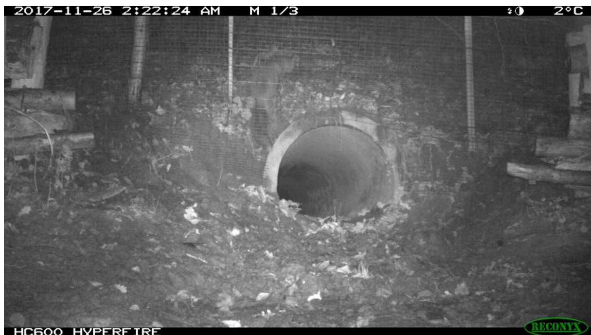
Figuur 25 - Vos kruipt onder het wildraster door dat tijdens de aanleg nog niet volledig tegen de grond aansloot aan de linker kant van de faunabuis.
