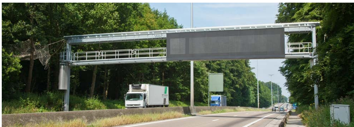
Figuur 11 - De signalisatiebrug die aangepast werd met een goot bovenop de constructie om ook te fungeren als boombrug voor eekhoorns (foto: Wim Van Calster – Departement MOW).
