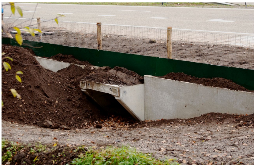
Figuur 4.14 Aanleg kleine faunatunnel (foto: Arfman).
