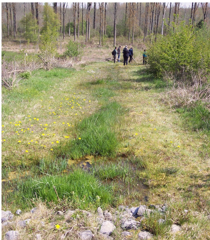
Figuur 2.7 Het ecoduct is klaar, maar voldoet het ook aan de klanteisen? Op dit ecoduct in het Groene Woud werkte na enkele weken de waterpomp niet meer, waardoor de natte verbinding voor de doelsoort kamsalamander droog viel. Koeien hielden de vegetatie mooi kort, maar vertraptten ook de oevers van de poelen. Ook in de gebruiksfase blijft verifiëren en valideren noodzakelijk (foto: Dennis Wansink).
