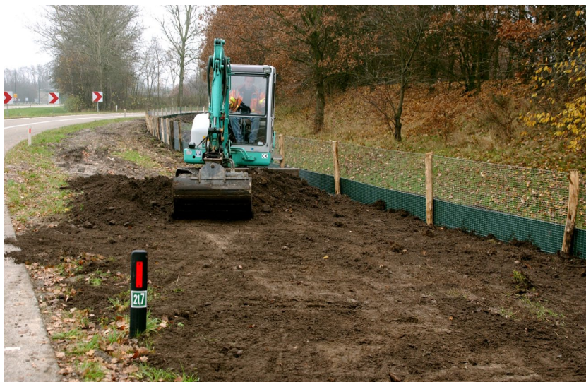
Figuur 4.15 Aanleg rasters en amfibieschermen (foto: Arfman).
