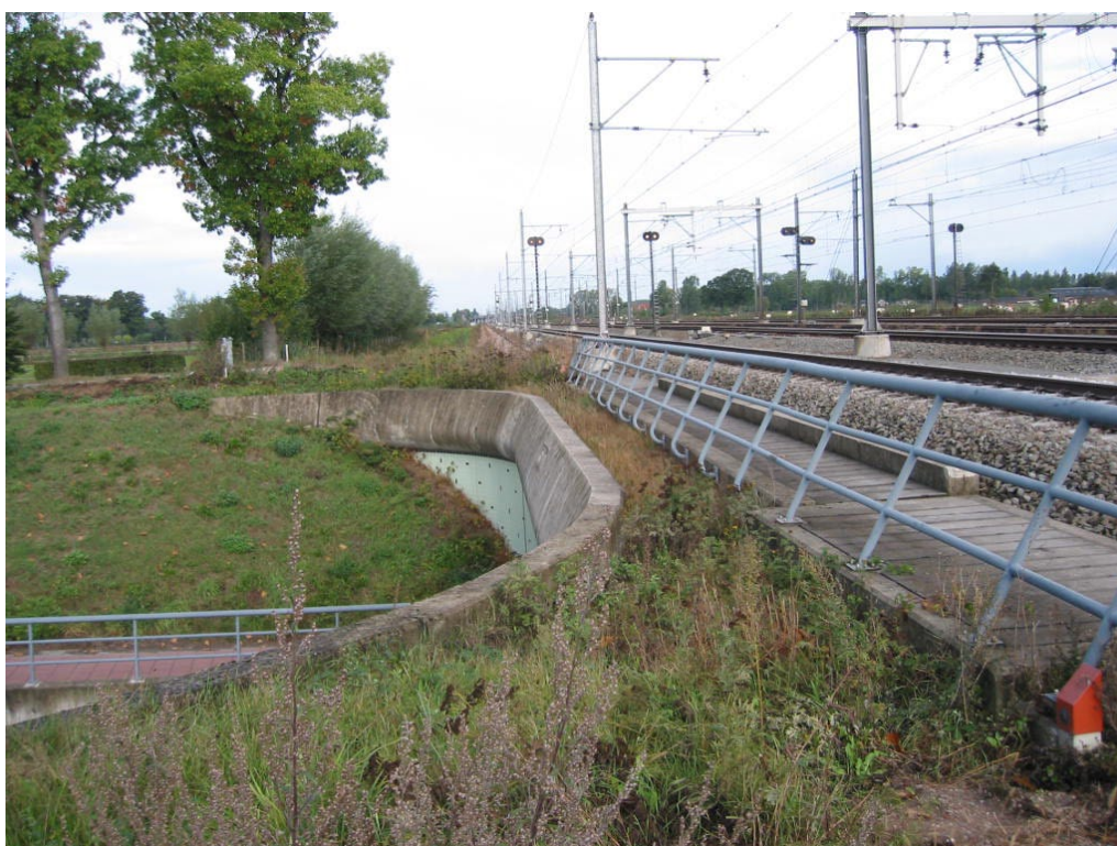
Figuur 3.2 Bij de aanleg van nieuwe (spoor)wegen kunnen bruggen iets breder worden gemaakt, zodat de berm over het viaduct kan doorlopen en zo een verbingszone voor fauna vormt (foto: Prorail).
