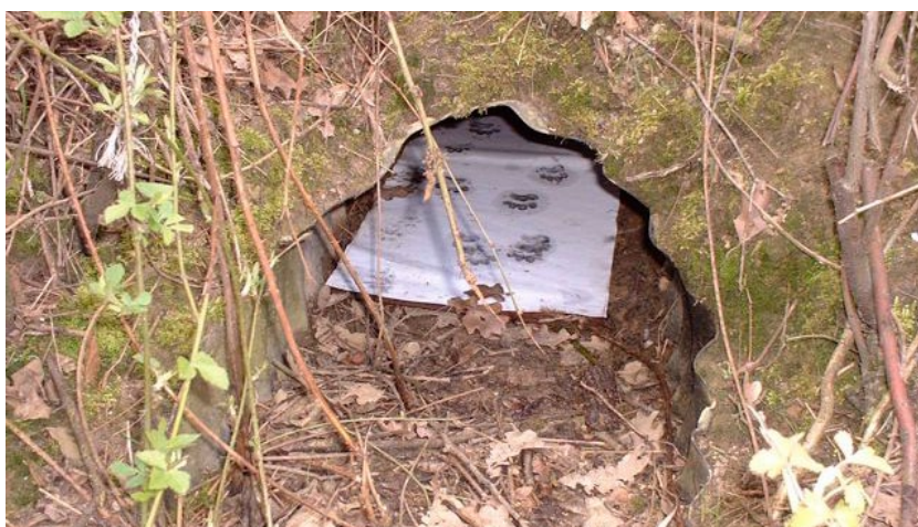
Figuur 6.22 Door dassen belopen papieren vellen met inkt in een kleine (spirosol) faunatunnel.
