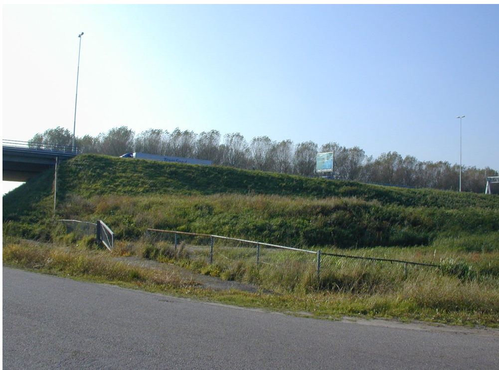
Figuur 5.3 Bij inspectie moet worden bekeken of werkpoorten gesloten zijn en blijven.
