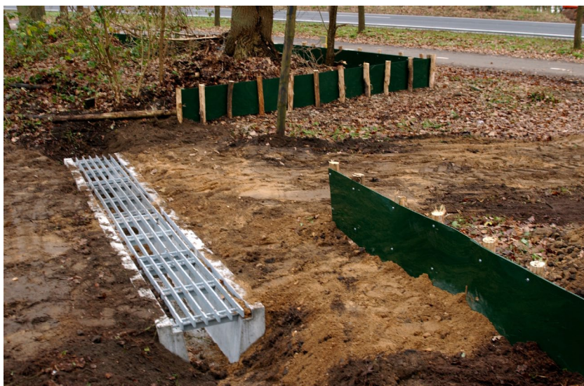
Figuur 4.20 Aanleg roostertunnel in een zijweg (foto: Arfman).
