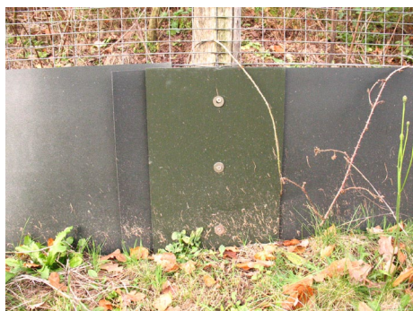
Figuur 5.13 Kier hersteld.
