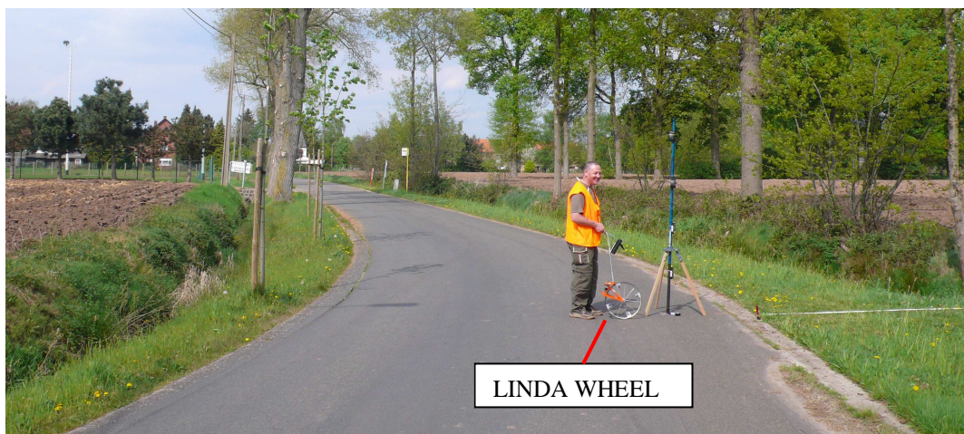
Figuur 4: Bepaling van ondergrondse kabellocatie
