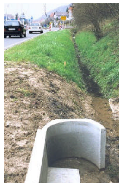
Foto 4.5. en figuur 4.13.: Principe van een stop- of keerwand aan het uiteinde van een geleidingswand. Het is de bedoeling dat de dieren opnieuw in de richting van de tunnel worden gedwongen.
