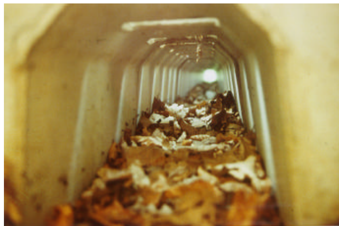
Foto 5.2.: Amfibieën betreden gemakkelijker een tunnel wanneer aan het uiteinde licht is te zien of licht in de tunnel valt (foto: KANN).
