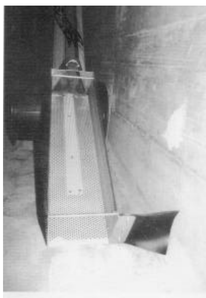
Foto 6.9.: Geleidingsstuk uit hard rubber tussen loopplank en bekkenwand. (foto: Bärtschi & Schelbert in Zumbach et al., 1996)
