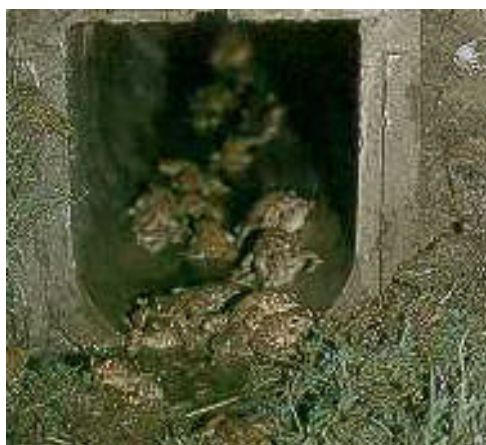
Foto 5.1.: Tunnels met een kleine diameter worden doorgaans gemakkelijker door amfibieën voorbijgelopen en worden aarzelend betreden. In bepaalde gevallen kan voor de tunnelingang ophoping van dieren plaatsvinden. (foto: ACO)
