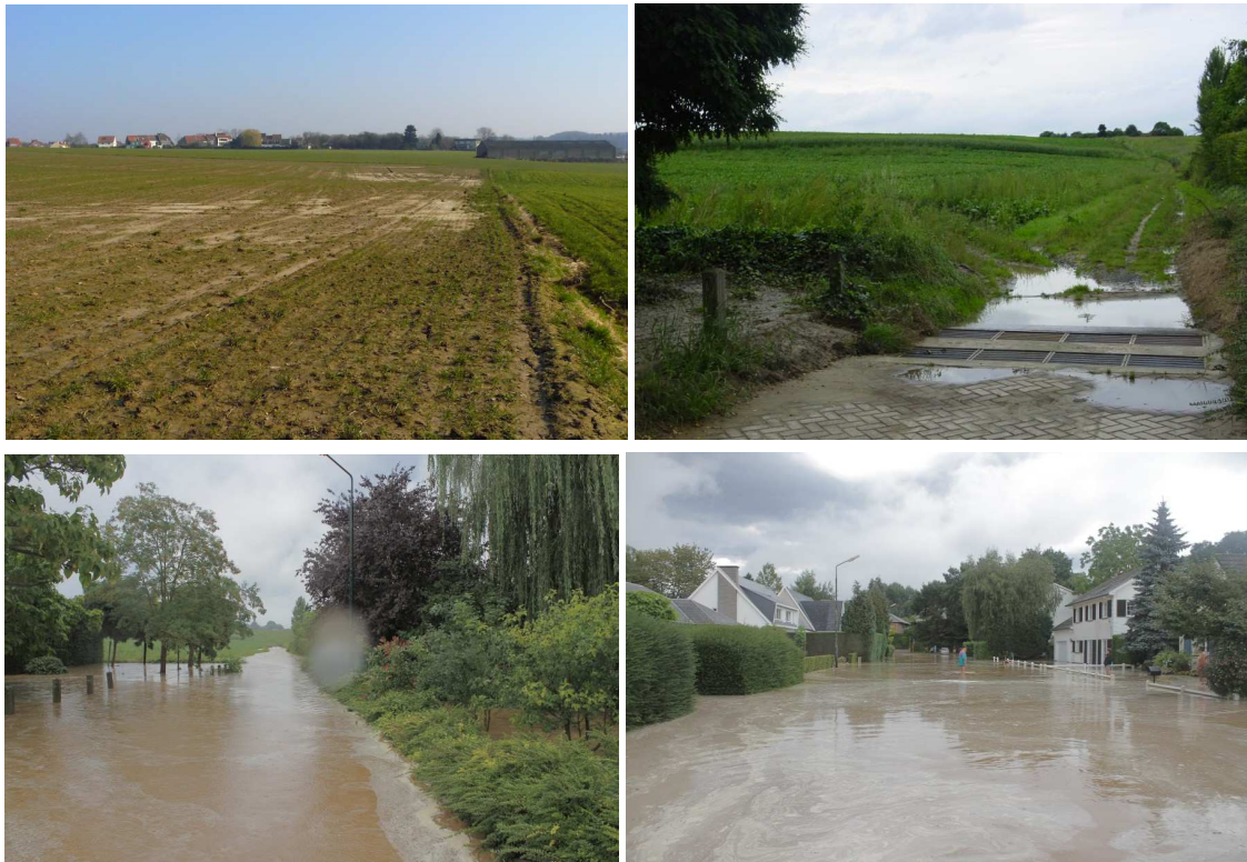
Figuur 136. Situering van het knelpuntgebied Boesdaal. Boven links: geulen en sedimentatie; Boven rechts: dubbel rooster in 'Hof ten Boesdaallaan' (verlengde van de veldweg) om het afspoelende water en sediment op te vangen; Onder links: overlast in 'Hof ten Boesdaallaan'; Onder rechts: overlast op de Ijsvogellaan te Sint-Genesius-Rode.
