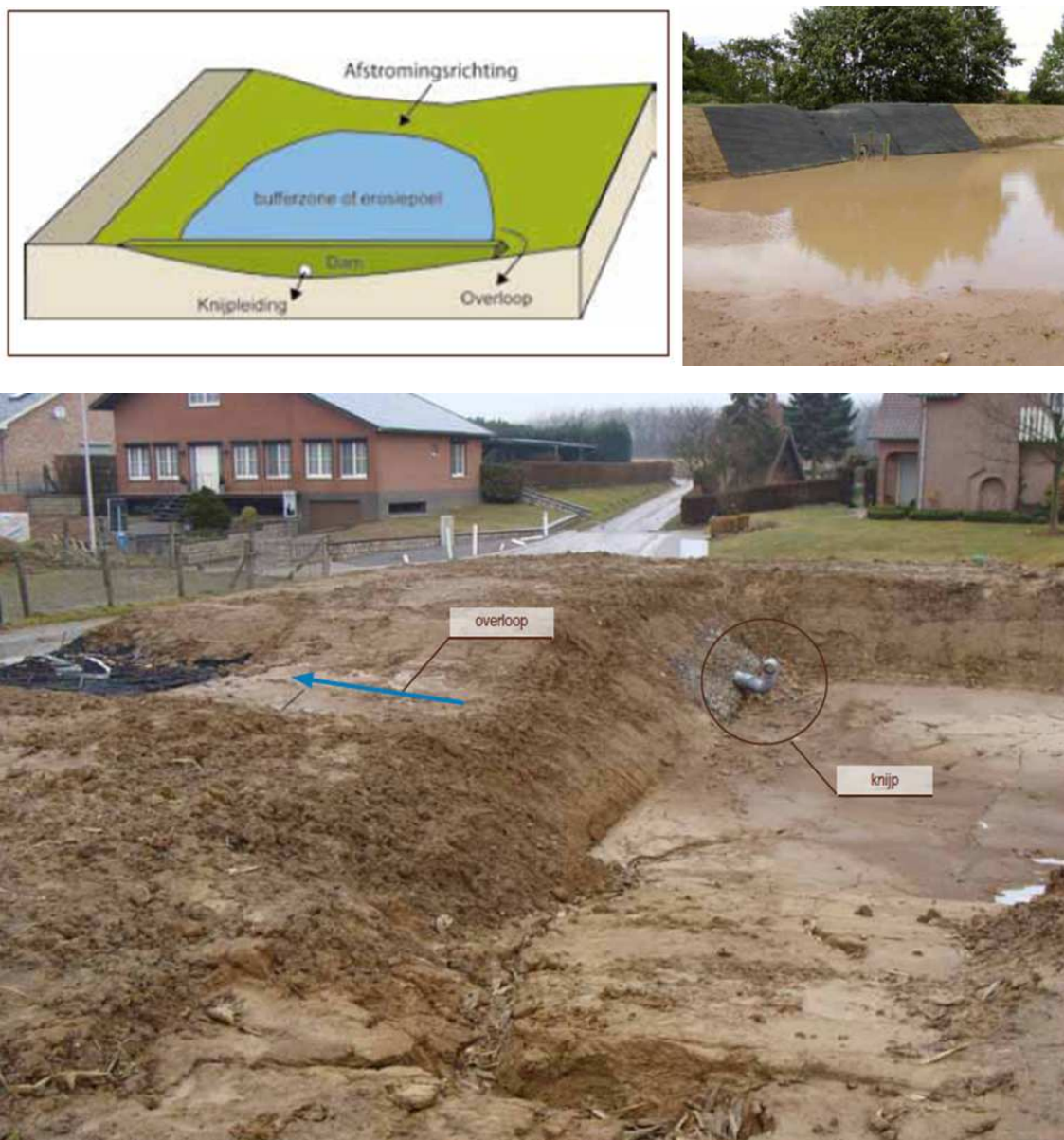
Figuur 2. Opvangsysteem voor erosiebestrijding achter een aarden bufferende dam.
