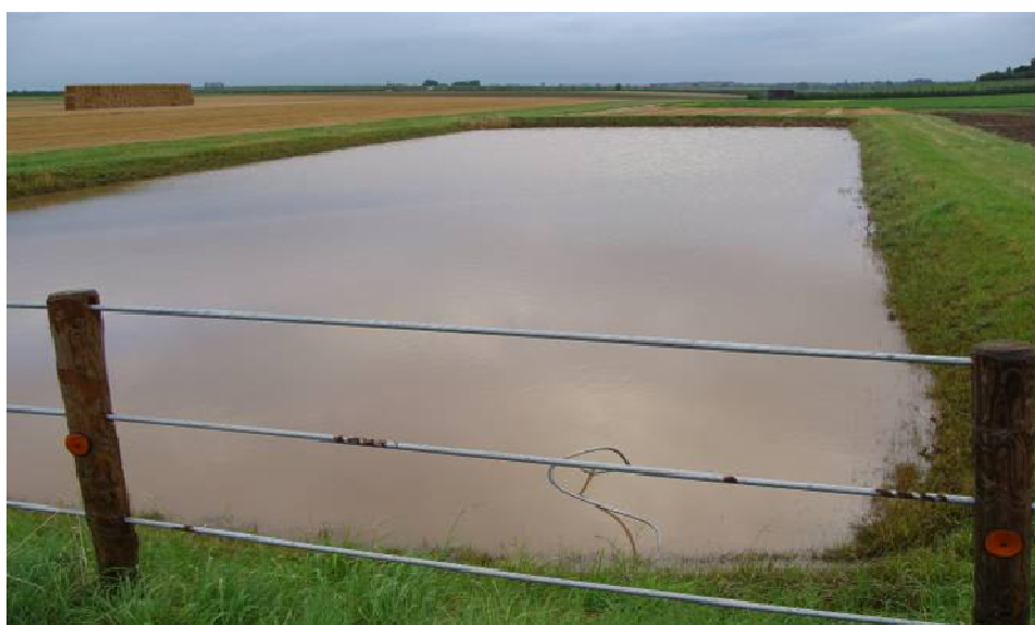
Figuur 67. Buffer met vertraagde afvoer langs de Heulen gracht, opwaarts van de San Dimas meetgoot.
