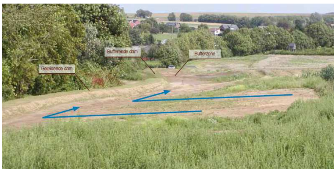
Figuur 3. Opvangsysteem voor erosiebestrijding via een geleidende dam.
