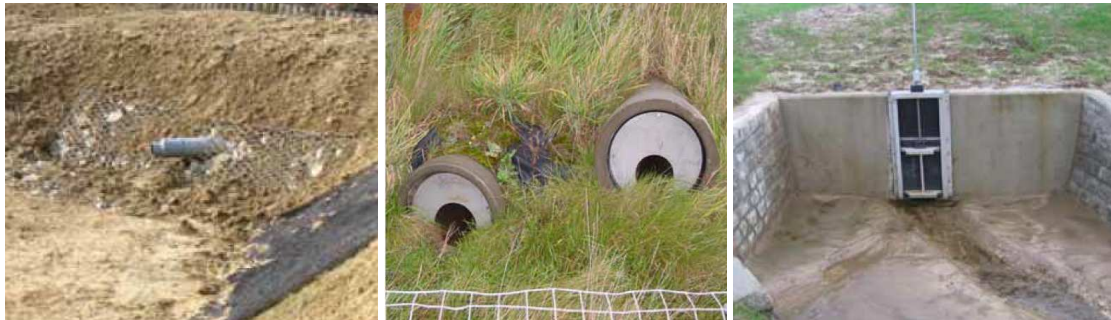
Knijpconstructie via buis
