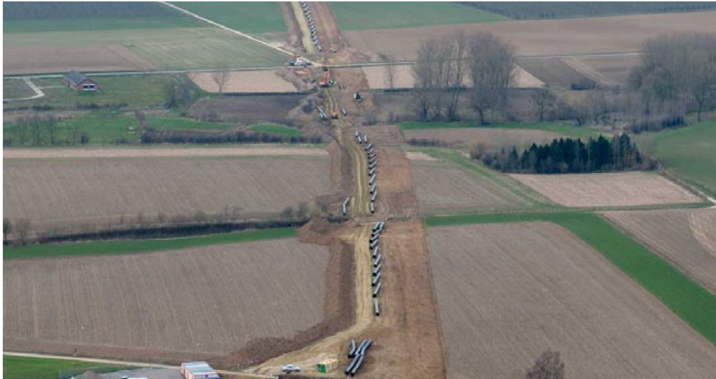
Foto: werkstrook tijdens de aanleg van een buisleiding
