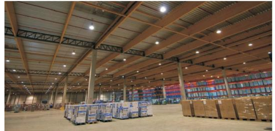
Figuur 13: foto's binnenkant bedrijfsgebouwen TDL (© Bolckmans nv)
