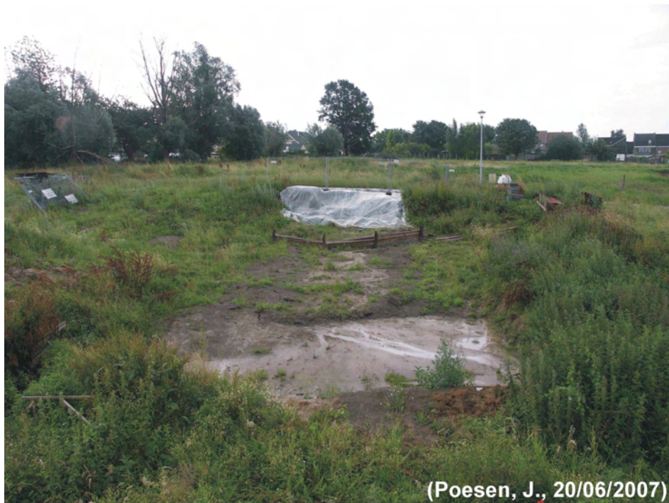
Foto 1 : Overzicht van GV. 145. Let op de artificiële berm (gedeeltelijk afgedekt met een plastic folie) die deel uitmaakt van de kelderput, de verschoven Berlinerwand en de gedeeltelijk met hellingsmateriaal bedekte laag gestabiliseerd zand.
