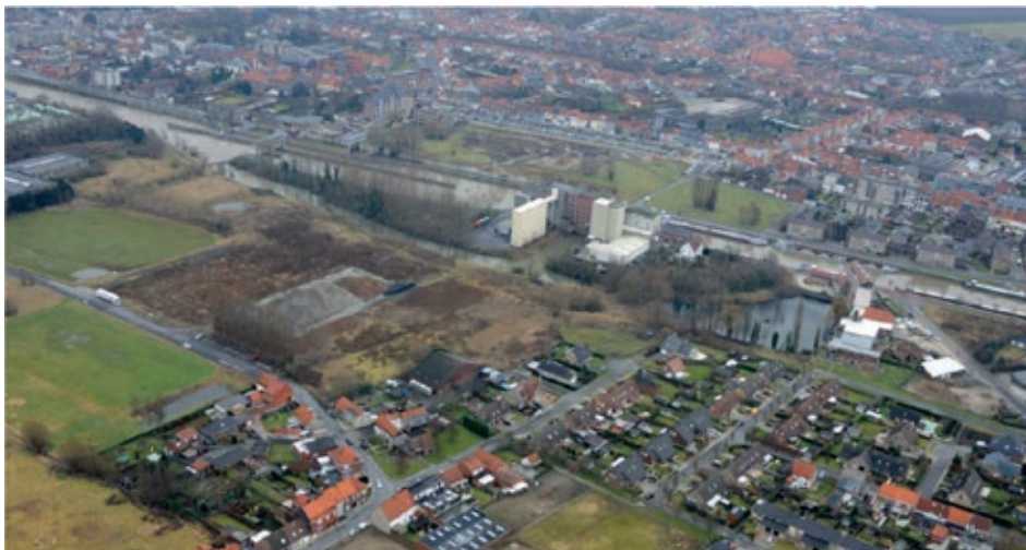
Figuur 56: Zicht op de site van woonpark Harelbeke - Kuurne in 2012 (Bron: Intercommunale Leiedal, 2012, eigen bewerking)
