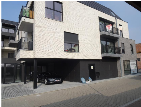
Figuur 1: Foto van de buitenzijde van de 12 kV cabine gelegen in de Bloemestraat in Maldegem.
