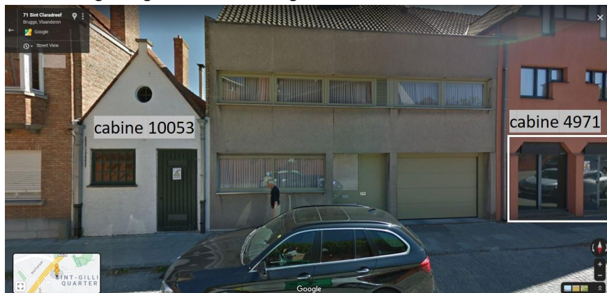
Figuur 1: Foto van de buitenzijde van de 11 kV cabines gelegen in de Sint-Claradreef te Brugge (foto: GoogleMaps).
